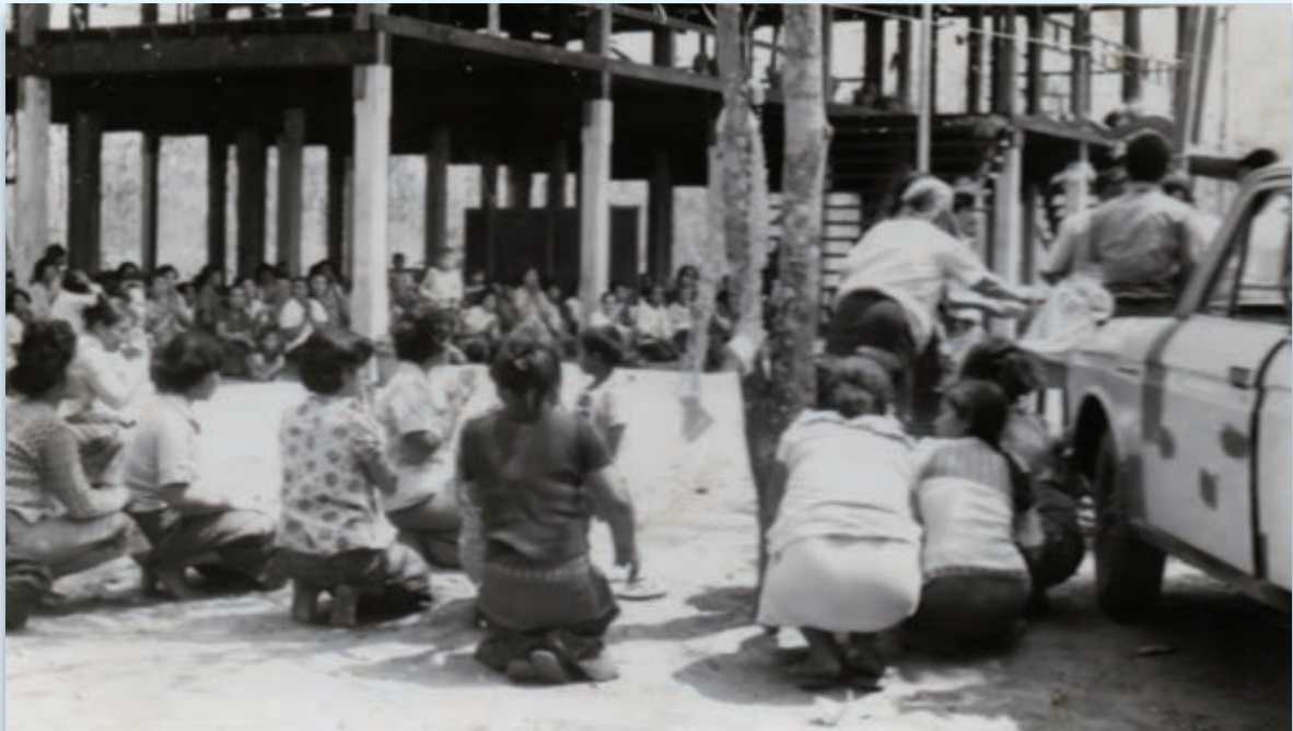
ภาพขณะกำลังก่อสร้างศาลาวัดป่าศรีไพรวัลย์
